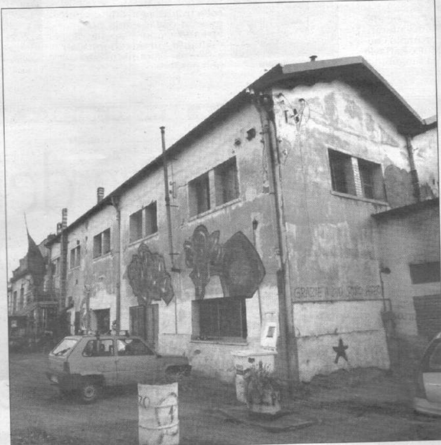
Un capannone dell'area delle ex Officine
